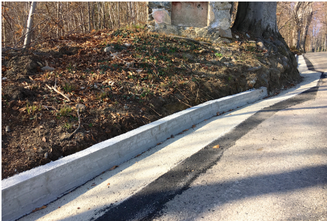
Un tratto delle ultime cunette realizzate
