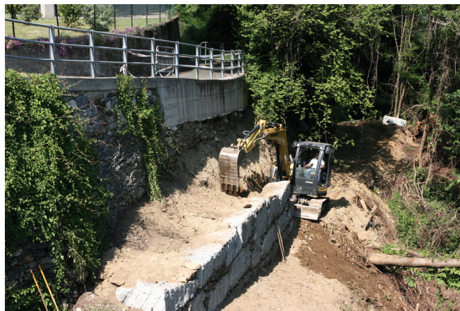
La posa dei massi nella ripresa lavori del "dopo lockdown"
